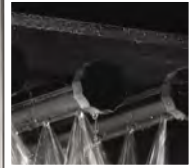
Zone de lavage
